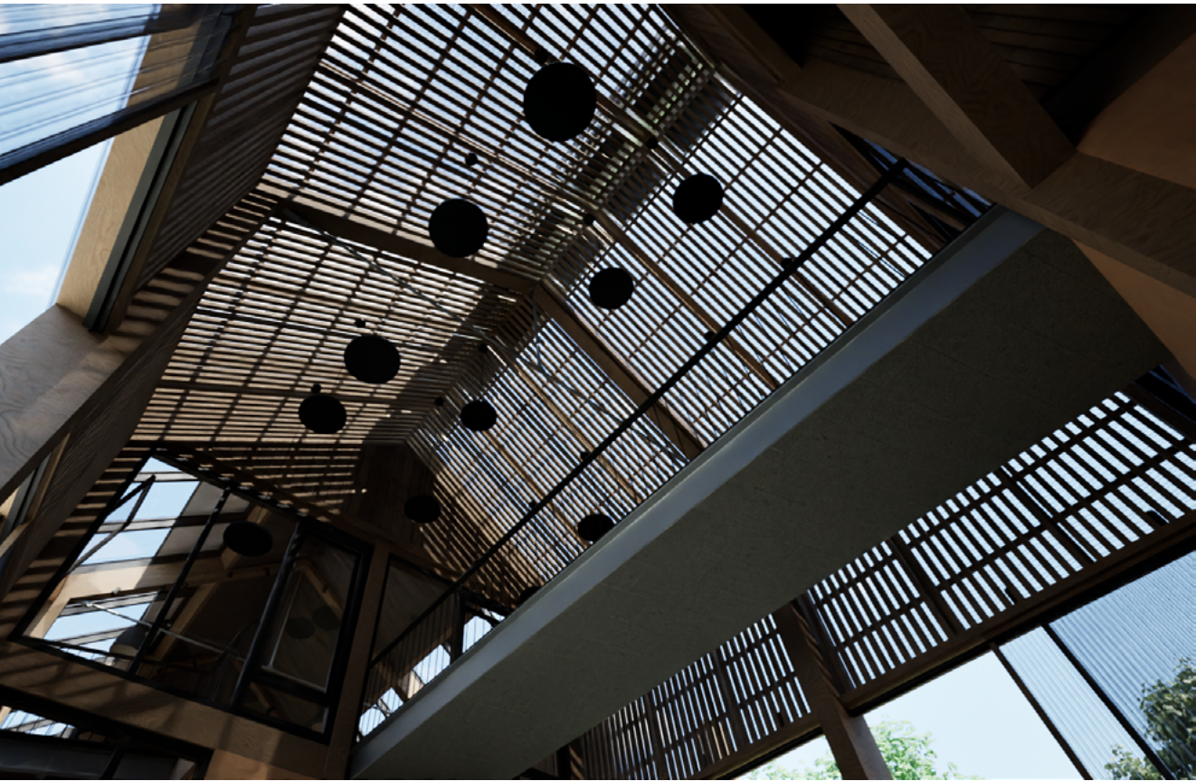
Vue de l'atrium et de son système de filtrage de la lumière zénithale
